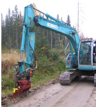
0,6/1 kV kabelplöjning
