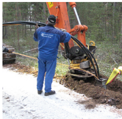
24 kV kabelplöjning DRYREX AHXAMK-W
